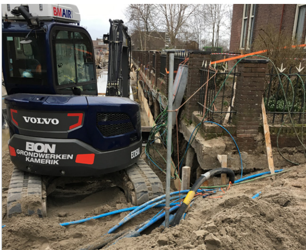
Afbeelding 14 De gevolgen van bodemdaling zijn goed zichtbaar in het gebied. De aansluitingen tussen de zakkende openbare ruimte en de gefundeerde woningen moeten steeds worden aangepast (boven en midden), leidingen en rioleringen moeten opnieuw worden aangelegd (linksonder) en huizen die niet gefundeerd zijn, kunnen verzakken (rechtsonder).
